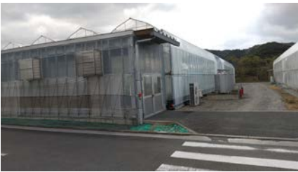
植物工場4 西面（北西側からの写真）
